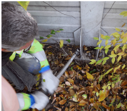
Figura 6 – Esempio di controllo del serraggio dei tirafondi. L'origine riferimento non è stata trovata..
