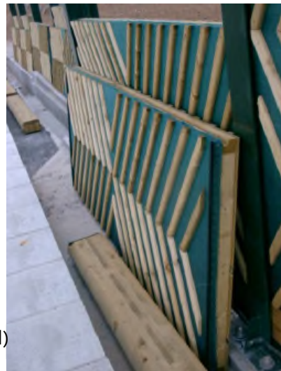
Figura 4 – Materiali fonoassorbenti utilizzati a) pmma/vetro; b) acciaio cor-ten; c) vetro stratificato; d) legno.
